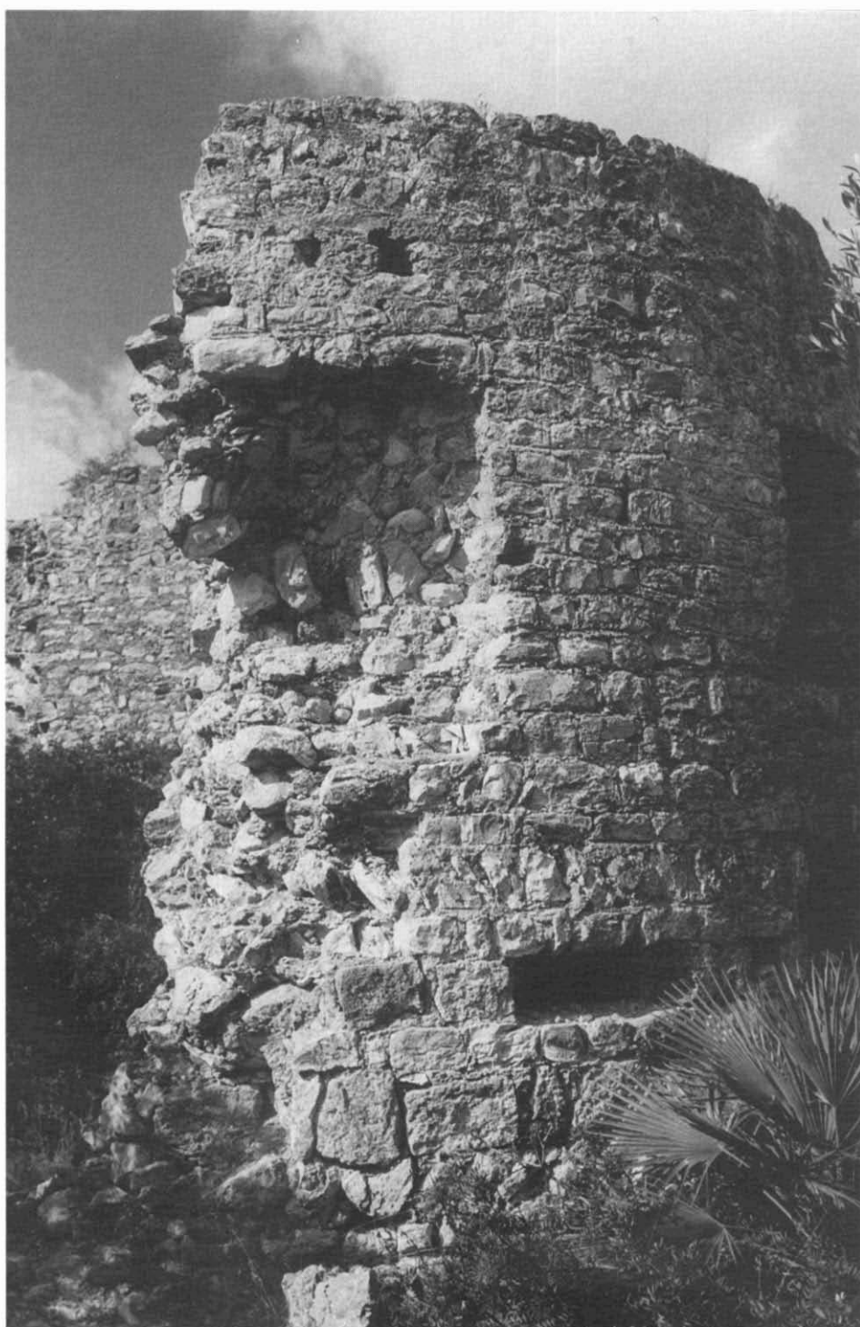
4. Torre circular central de la qual només queden aquestes restes.
