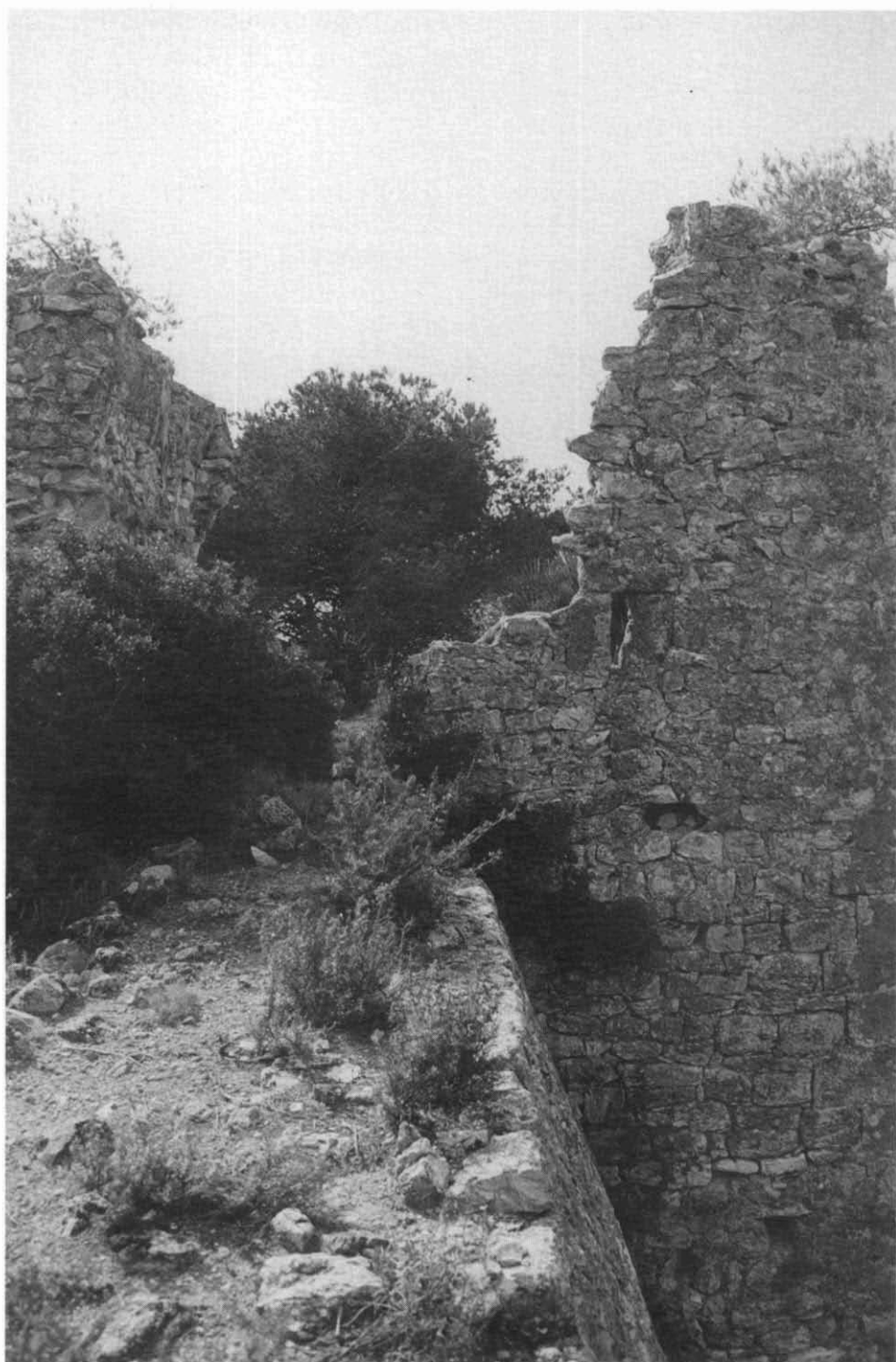
5. Vista de la torre de dues plantes des del mur en talús. A primer terme veiem una finestra o espitllera.
