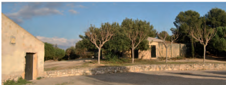
El dipòsit de La Creueta, amb l'era i pallissa del Gatell en primer terme.
