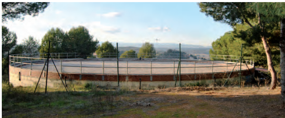
El dipòsit nou (núm. 2) de Sant Antoni que distribueix l'aigua del Transvasament.
