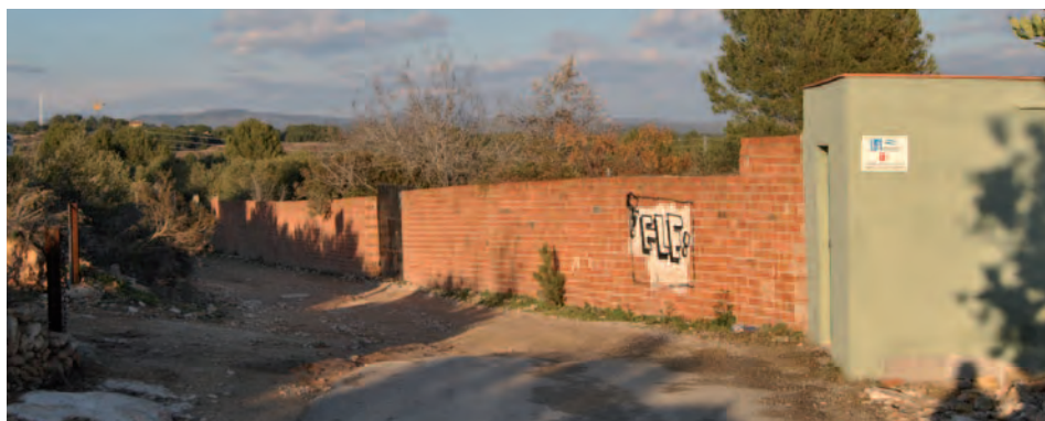
Paratge d'emplaçament dels pous nominats 2 i 3 del Camí de La Nou, amb la caseta elèctrica annexa.
