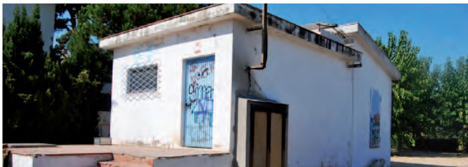
L'estació de bombeig d'aigües residuals (EBAR) de Baix a Mar, vora el Parc del Canal.
