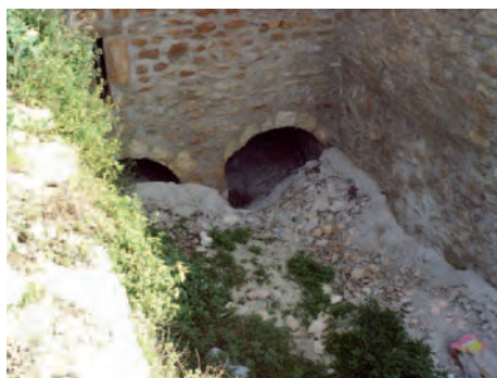
Canals de sortida; estat anterior a la neteja. El desenrunament es va dur a terme fent servir una pala mecànica amb la qual cosa es va perdre la possibilitat de fer una anàlisi exhaustiva de les restes materials retirades.
