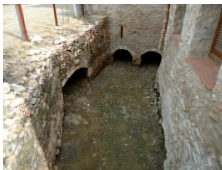
Sortida dels cacaus. A l'esquerra s'observa el 3er canal aparegut al fer el desenrunament i neteja dels altres dos canals.
