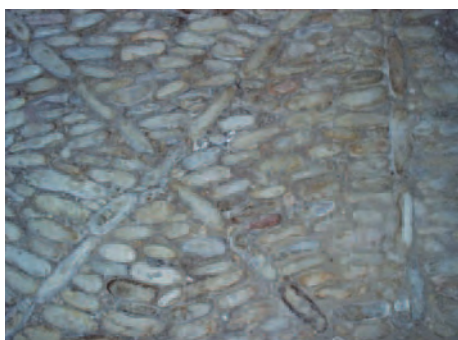
Graons des de la porta nord fins a la sala de moles. Detall. S'aprofita la col·locació dels còdols, per evitar desgast i pèrdua de terra, per realitzar un dibuix decoratiu característic.
