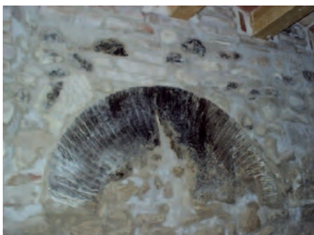
Mola formant part del mur oriental. Es poden observar les restes de foc, en ella i al seu al voltant.
