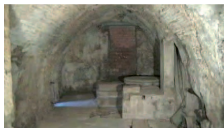
Sala de moles. Al fons s'observa la porta que dona al carrer. Al mur de l'esquerra es pot veure, parcialment, la petita finestra en espitllera. A la dreta, el banc i les moles. Es pot distingir, clarament, el sostre en volta de canó lleugerament apuntada, i les marques deixades per les canyes de la cinbra.
