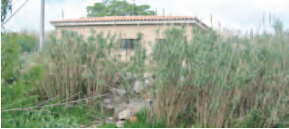
Aspecte de l'estació de bombeig des de la llera del riu
