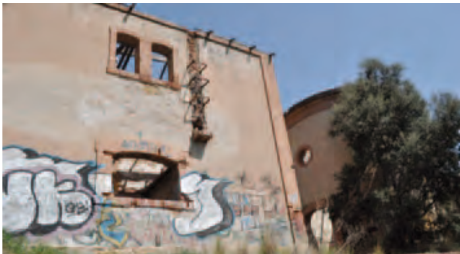
Edifici de l'equipament de la Renfe que inclou el dipòsit.
