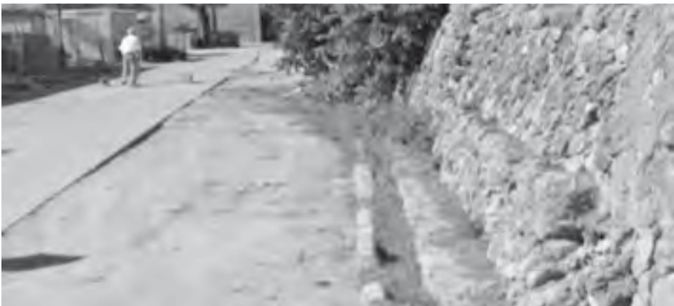
Canaleres darreres del camí dels Credos, que assolirien fins els safarejos municipals
