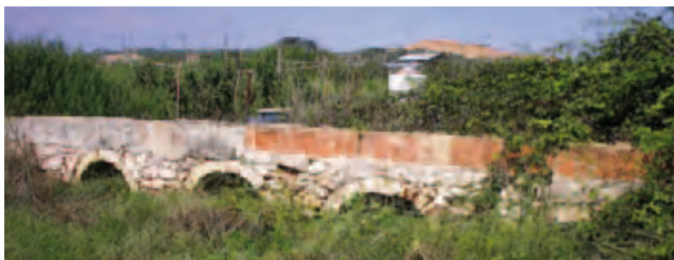
Canalera de transport d'aigües a l'entorn de la sínia
