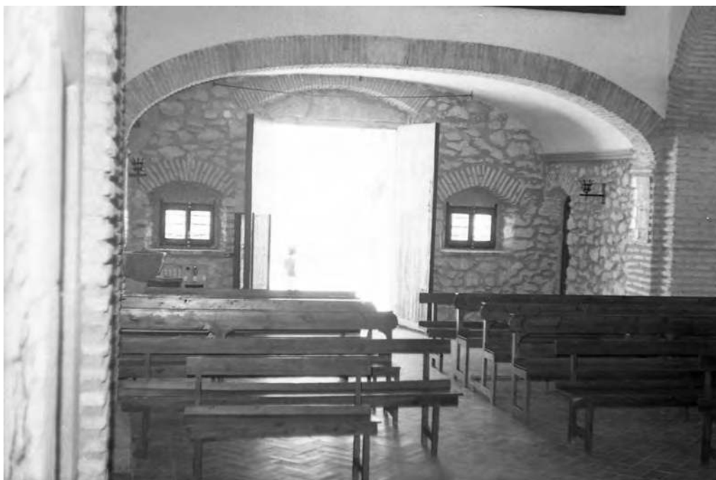
Interior de l'ermita, després de les darreres restauracions, amb les parets parcialment repicades.
