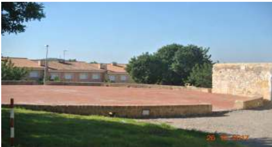
Era de l'Yxart amb la seva pallissa a la dreta, on es veu l'accés tapiat per abocar-hi la palla. El muret està fet per una coronació (nomenat sardinell) perimetral de maons.
