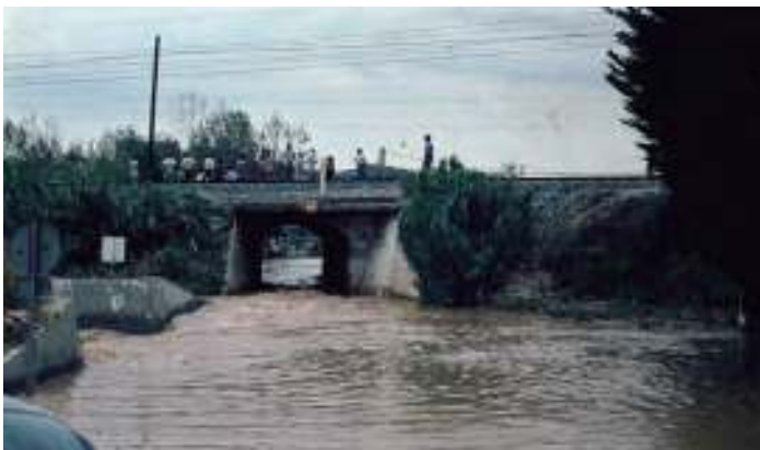
Fig.22. Això no és pas el Gaià, sinó els efectes d'uns aiguats. El pont sota la via del tren és el que portava a la carretera sense passar pel poble (ara és més ample i s'hi accedeix per una rotonda)
