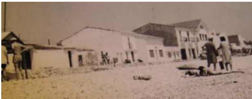
Fig. 3. Aquest aspecte tenia una part del carrer de davant, a partir de l'actual 63
