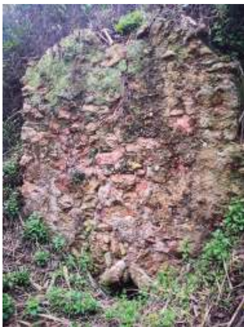
Fotografia 6. Captació de la Mineta a la sèquia del molí del Pas, a pocs metres de la resclosa de la Riera. Restes de l'última construcció
