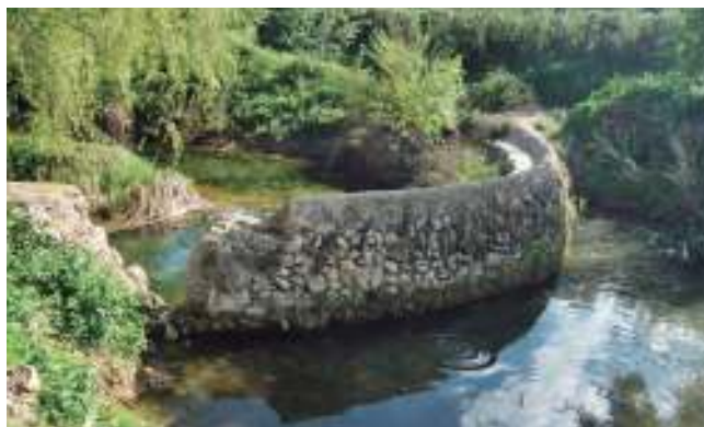
Fotografia 2. Resclosa de la Riera l'any 2012. Aquesta resclosa no va ser feta d'obra fins el 1912
