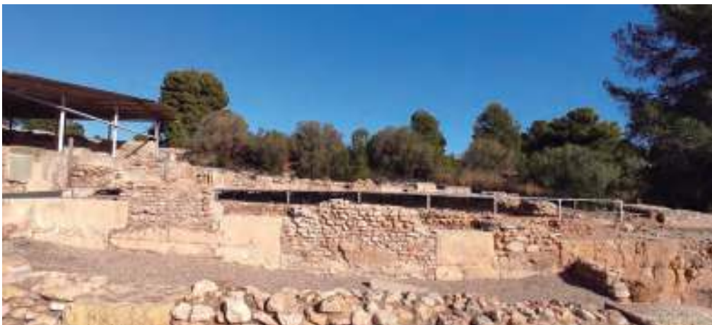
Fig. 9. Murs de tancament amb carreus, possiblement, suportant encavallades (foto autor)
