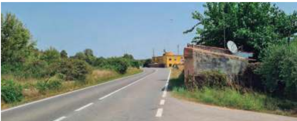
Fotografia 12: Caseta a “La Torreta” on hi havia la marca del nivell de les aigües
