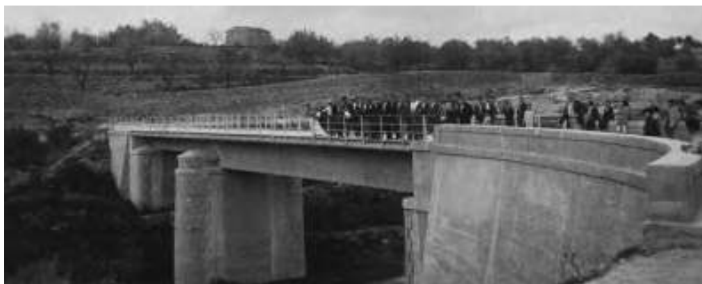
Fotografia 18: El nou pont del Catllar
