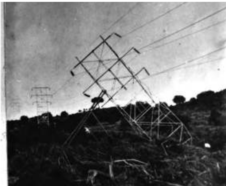
Fotografia 13: Torres de “La Canadiense” tombades a causa de la gaianada (Fotografia Antoni Terrafeta)
