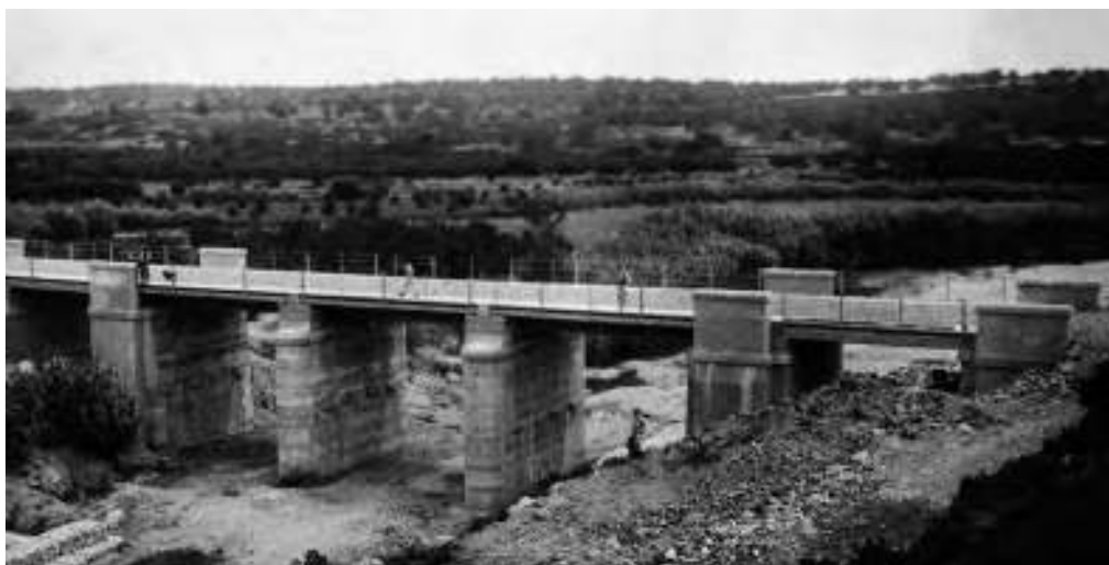
Fotografia 17: El pont nou del Gaià a la Riera
