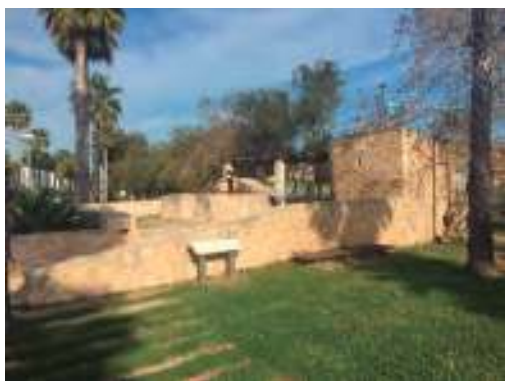
Figura 11. Sínia de l'hort de Pau a la vora de la via del tren
