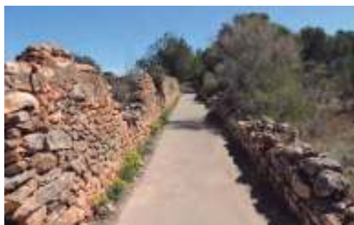
Figura 14. Aspecte actual d'un tram del camí de la riera a Torredembarra (a la zona dels quatre camins) a l'alçada on se situa l'assentament romà de La Casera)
