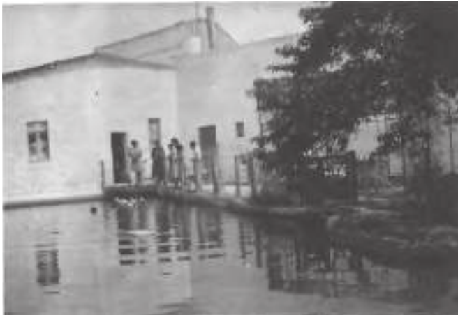
Edifici del molí amb la bassa
