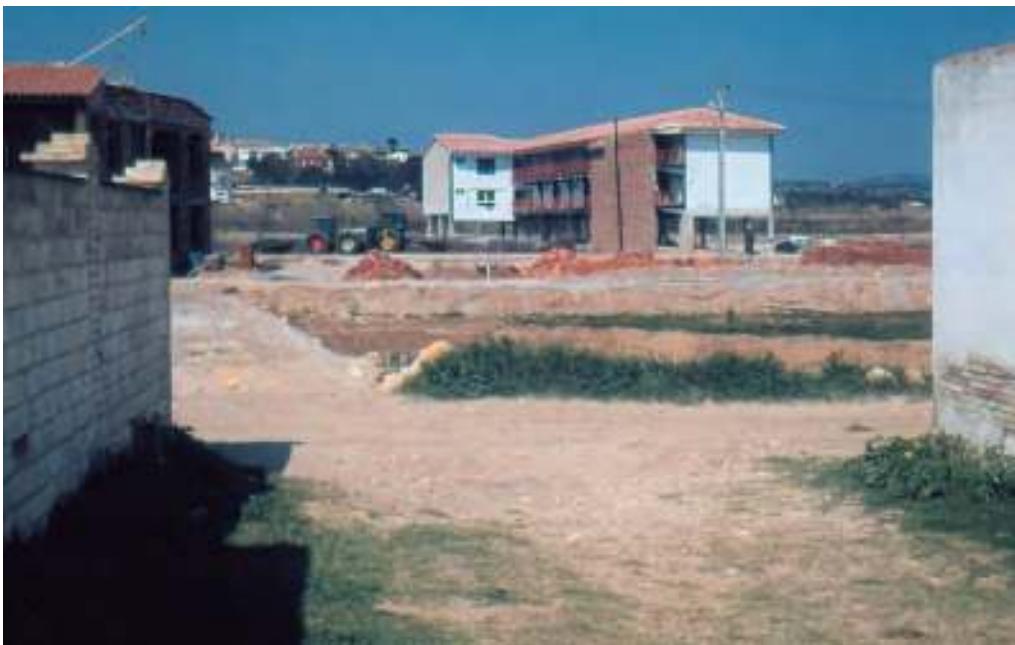
Figura 10. L'Hotel Yola en construcció
