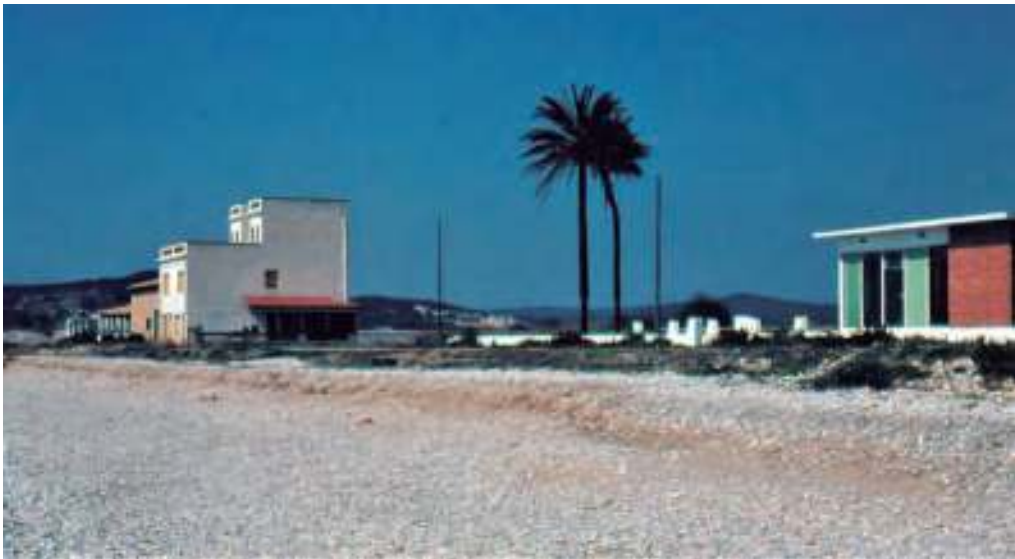
Figura 9. La caseta d'informació de la urbanització apareix a la dreta de la imatge
