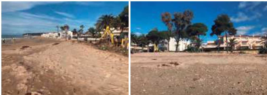
Figures 48 i 49: En les dues fotos superiors es mostra l'operació d'arrencament parcial de la filada d'atzavares. Es poden observar les zonificacions de trams més gravosos o arenosos separats per bermes, indicadores de les diferents fases de retreballament dels sorrells litorals. La foto de la dreta mostra el predomini de sorres en el tram superior, front al tram amb còdols del tram inferior mullat
