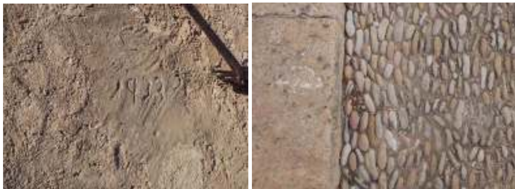
Figures 39 i 40: Esquerra : Mur de la Pallissa de l'era del Senyor: arrebossat l'any 1933 segons mostra el grafit, amb àrids, damunt d'un altre anterior, també amb les gravetes, visibles a l'esquerra. Dreta : Esgrao de l'escala de l'església, amb els replans de còdols com la majoria de la part del poble. L'esglao amb pedra de la Savinosa-Altafulla, amb un equínid (eriçó de mar) fòssil
