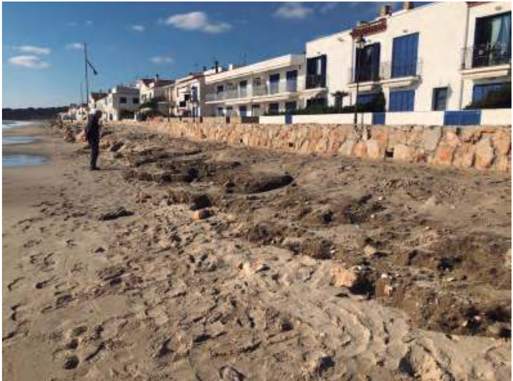
Figura 43: A l'extrem nord del passeig no hi ha escullera defensiva i les pluges de Santa Tecla de 2022, amb la seva erosió per les boques de drenatge, descalçaren les sorres que tapaven els materials antròpics o del basament de l'antic camí o passeig original
