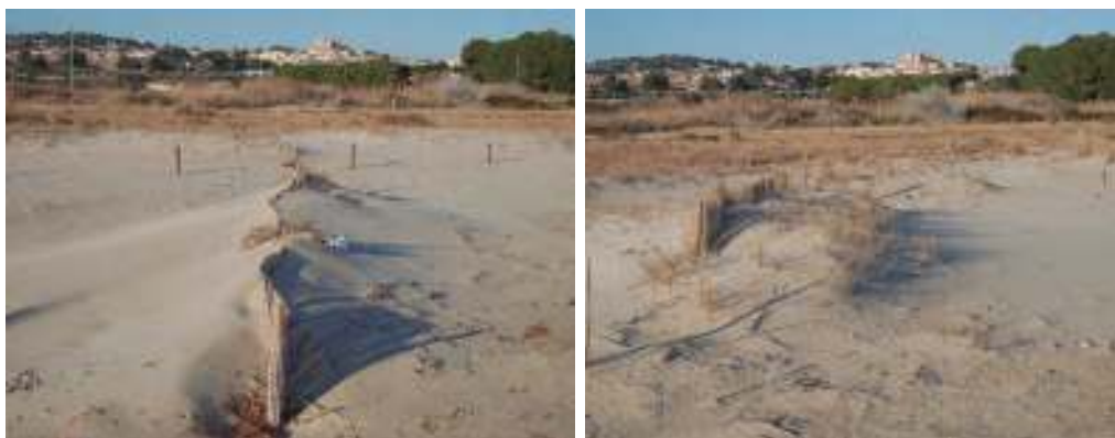
Fotos 62 i 63: En el sector de l'entorn de la Roca de Gaià i la platja del Vinyet, els canyissos instal·lats com a captadors eòlics funcionen com generadors de sorral·ls eòlics de sorres fines
