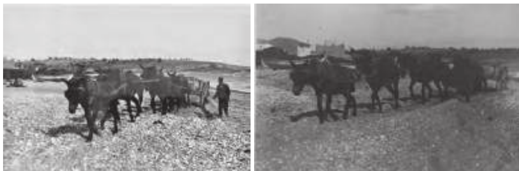
Figures 37 i 38: Una rècula de mules tirant del carro de trabuc per tragar còdols i arenes: Documents gràfics dels sistemes d'extracció de graves i sorres de la platja vers els vagons ferroviaris, amb el destí de terraplenar àrees pantanoses i inundables. Destaquem com els còdols semblen aparèixer especialment en la part superior més rentada i garbellada
