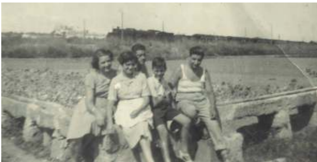
Fotografia 4: Joves al Vinyet, als anys 50. Aquí es pot veure un exemple de rec elevat (amb forma d'aqüeducte) fet amb canals de pedra picada, procedent de la sínia del Quim del Rúbio.
