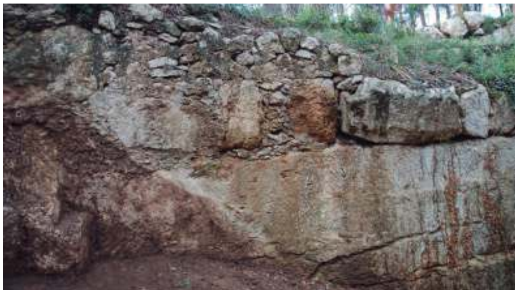
Fig. 7. Mur de contenció de la rampa d'accés al Mèdol
