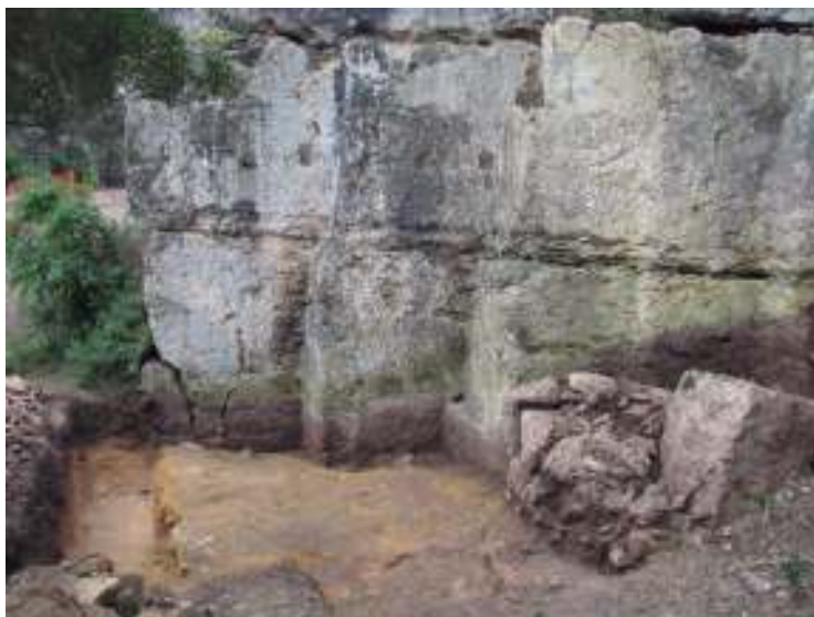
Fig. 16. Sondeig 300, amb els encaixos per a les bigues i el mur de límit de pedra seca (a la dreta)
