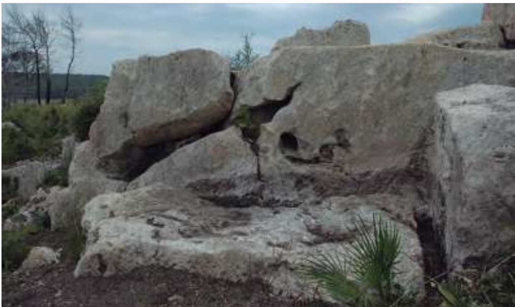
Fig. 15. Vista del sondeig 200; la roca mostrant forats d'origen càrstic
