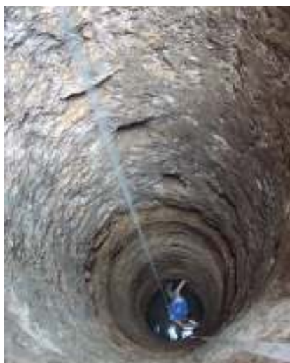
Fig. 21. Interior del pou, un cop acabada l'excavació, amb aigua al fons. Es veuen clarament els forats realitzats per facilitar-hi l'accés
