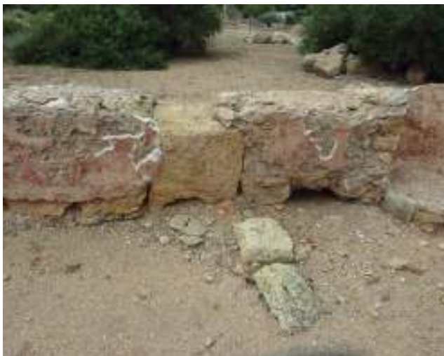
Fig. 10. Mur banqueta amb bloc de pedra (foto autor)
