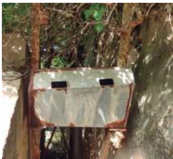
Fotografia 11. Catúfol de la sínia boja del Clos. Els catúfols eren metàl·lics amb forma de caixó trapezoidal per afavorir el desguàs. Els dos forats eren per fer entrar l'aigua
