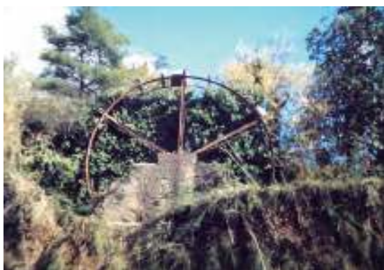
Fotografia 1: La s'inia boja del Clos el 1978 (en la s'iquia original, poc abans de les obres de revestiment de la s'iquia). Aquesta roda hidràulica és l'últim testimoni encara en peu dels diferents enginys per aixecar l'aigua que hi hagué al llarg del traçat de les s'iquies del Catllar i la Riera. Fotografia Josep Zaragoza
