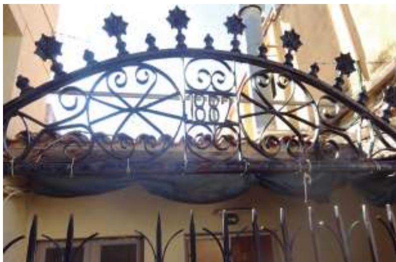
5. Porta ferrada i reixada principal que tancava la propietat pel carrer del Mar (1882)
