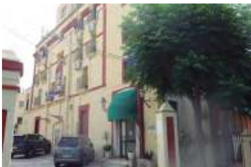
10. Hotel Sant Martí, façana nord
