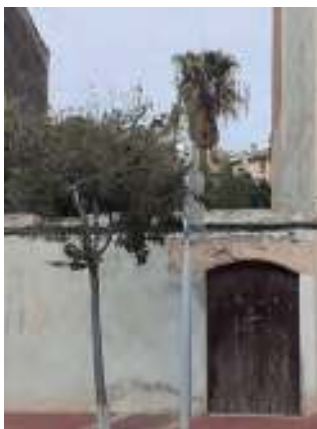
Fotografia 13: La porta a la carretera, amb el jardí al fons
