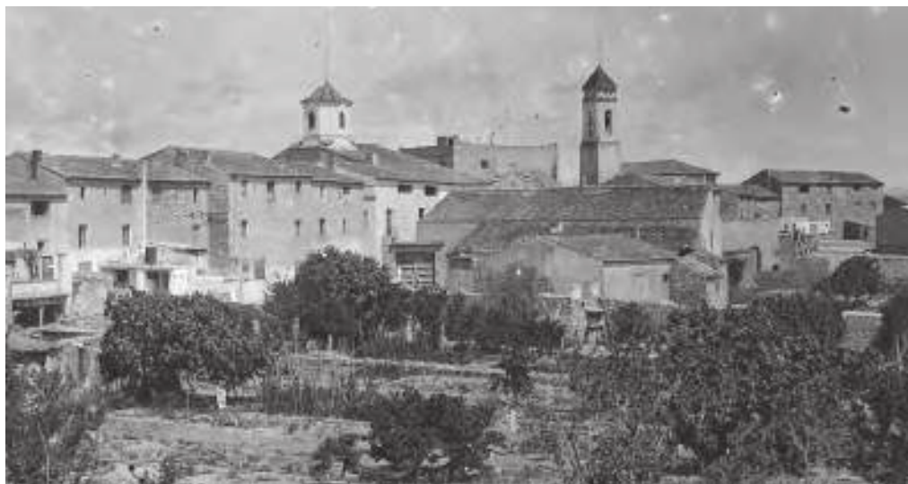
Fig. 5. Fotografia de l'Argilaga des del SE. Anys 1924-1929. (Fotografia: Col. Marc Salvador Gispert)
