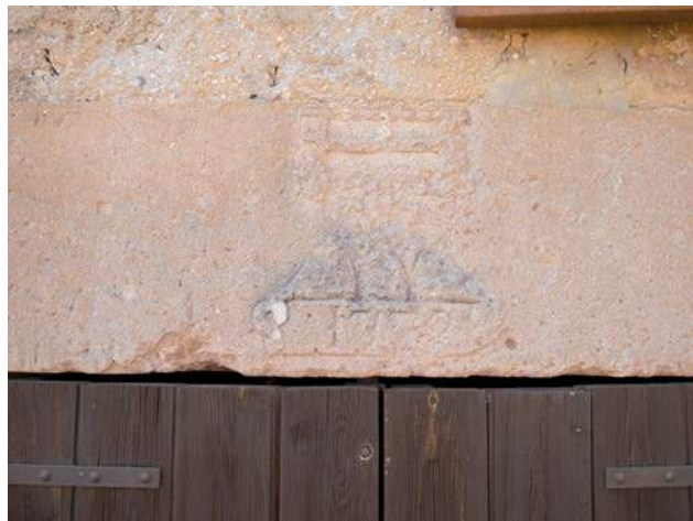
Fig. 15. Escut repicat de l'accés actual.
