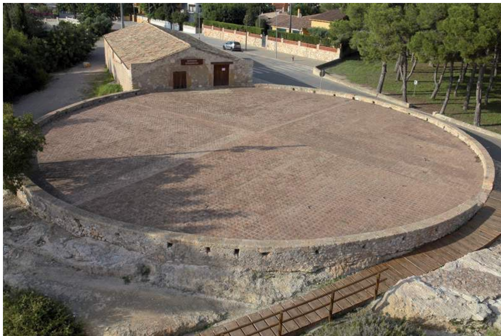
Fig. 1: Vista aèria del conjunt era i pallissa. Era elevada sobre l'entorn, amb carena de grans carreus 6 , pallissa enfonsada i sortides de pluvials.
