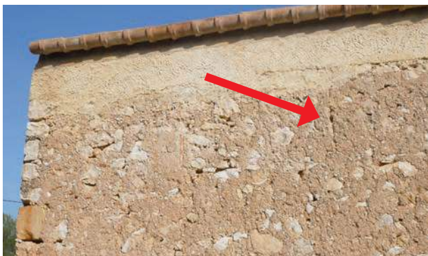
Fig. 12. Finestró del sector nord.
