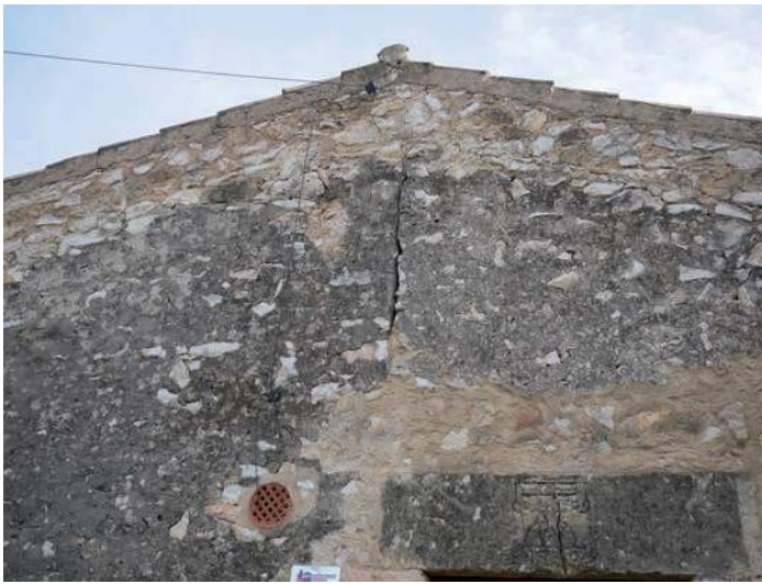
Fig. 4. Tancament nord de la pallissa amb els dos cosos rejuntats: el cos de la dreta (ponent) no encaixa amb el cos de l'esquerra, arrebossat i anterior.
