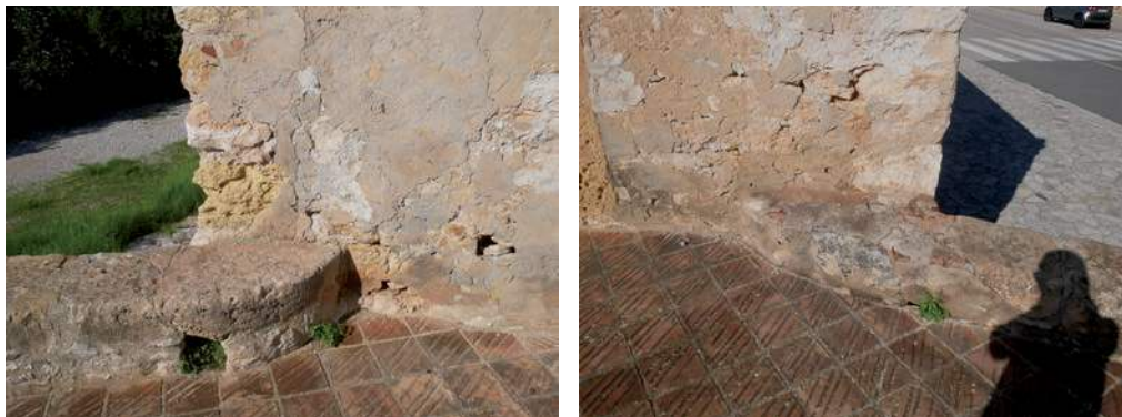
Fig. 2 i fig. 3. Diferents maneres d'encaixar els carreus careners amb la pallissa pel costat de ponent (esquerre) i pel costal de llevant (dret).
