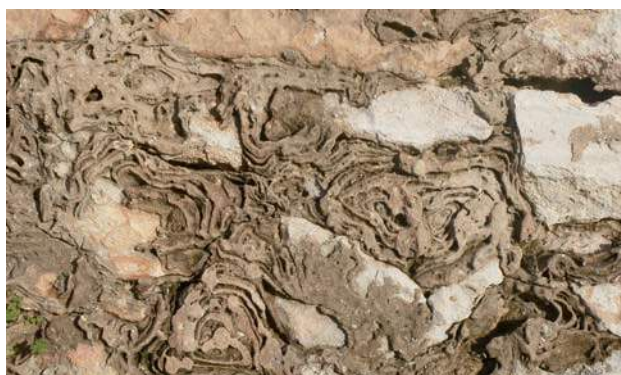
Fig. 10. Paret de ponent de l'era on es preserven artístics arrebossaments tapant blocs i pedres de calixt blanquinós.
